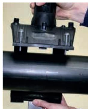
**N.B.: non è ammessa la foratura del tubo prima della saldatura, in quanto la saldatura del collare sarebbe gravemente compromessa.**
