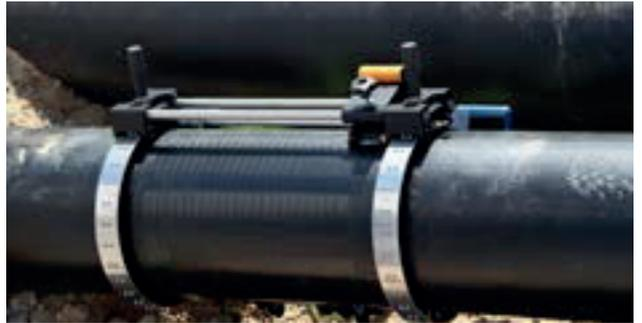
Il sistema di bloccaggio si aggancia al telaio garantendo così un facile posizionamento anche in condizioni difficili. Gli indicatori inseriti nelle cinghie, hanno la funzione di dinamometro per segnalare la corretta forza di trazione. La loro chiusura indica la corretta forza di serraggio. Dotate di robusti ganci di fissaggio, garantiscono un'affidabile e veloce operazione di montaggio
