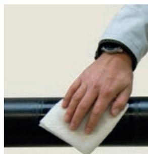
⑤ 5) Controllare e pulire la superficie interna del raccordo elettrosaldabile, che deve essere prelevato dalla sua confezione protettiva solo al momento dell'impiego.
