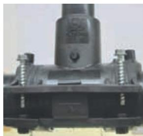
⑧ 8) Serrare le viti alternativemente fino al riferimento riportato su dispositivo di prefissaggio.
